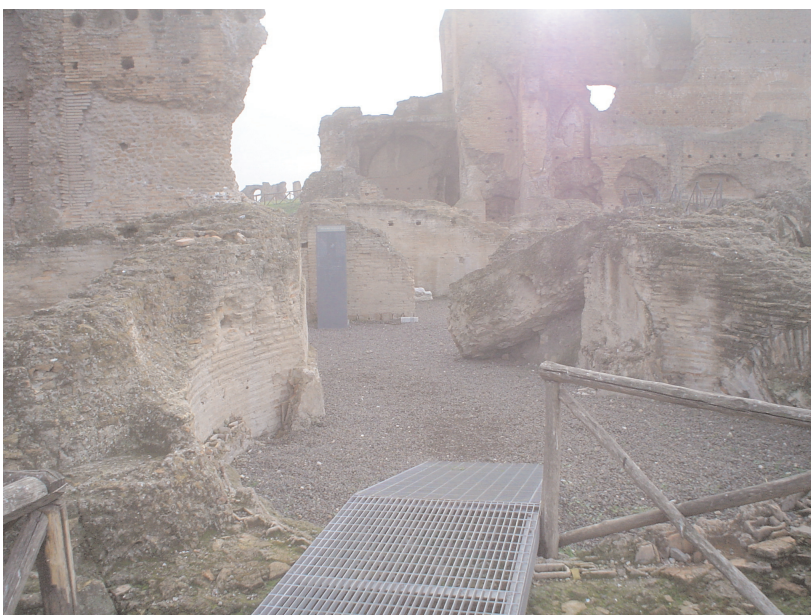
Una delle rampe in acciaio del Tepidarium dell'area termale della villa dei quintilidisposta per superare il dislivello dato dalle preesistenze e per preservare queste dall'usura del passaggio dei visitatori
