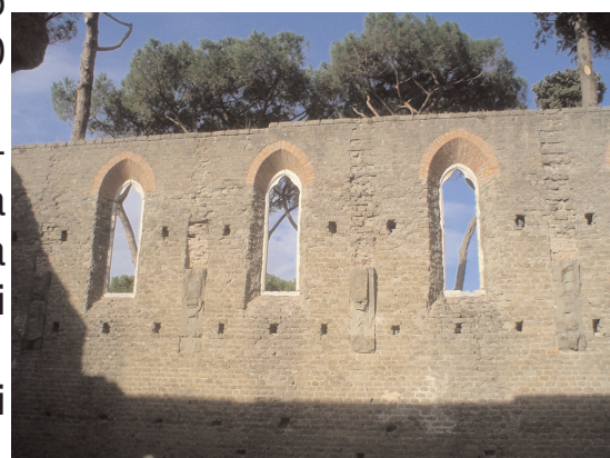
Chiesa di San Nicola di Bari inserita nella cinta muraria del Castrum Caetani . La chiesa è priva di copertura e fronteggia il Mausoleo di Cecilia Metella e il Palazzo Caetani addossato ad essa.
